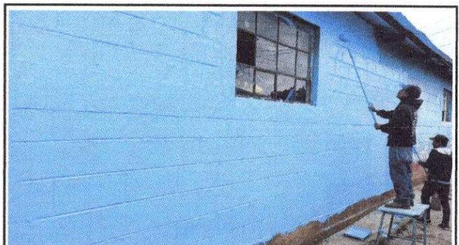
Foto 10: Trabajadores realizando la pintada de paredes de aulas exteriores
