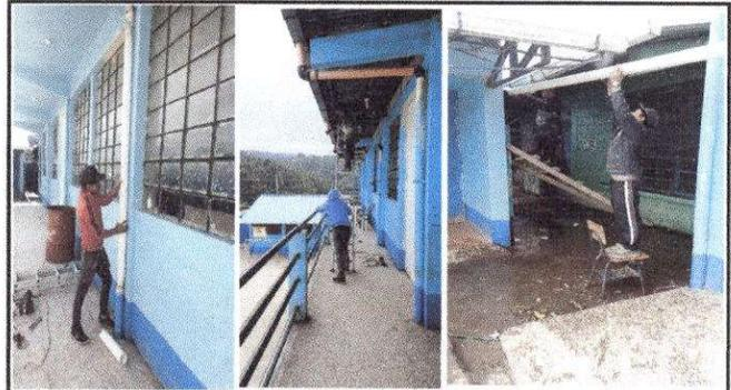
Foto 8: Instalación de baja de agua pluvial tubo PVC 3"
