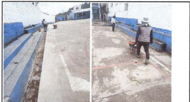
Foto 9: Proceso de reparación de cuneta de concreto en la cancha de baloncesto.
